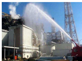
Refroidissement par camion de pompier
